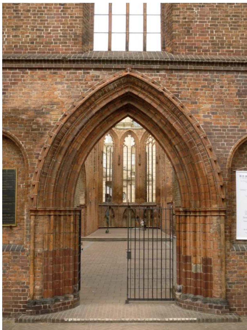
Abb. 1: Berlin–Mitte, Ruine der Franziskanerklosterkirche, Blick durch das Hauptportal an der Klosterstraße in die Ruine, 2013.
