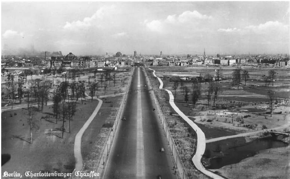
Abb. 5: Berlin, historisches Zentrum, Straße des 17. Juni nach Osten, 1945.
