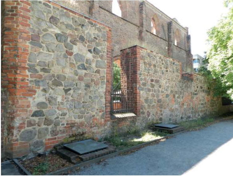
Abb. 9: Berlin Franziskanerklosterkirche, nördliche Seitenschiffsmauer der Kirche, die zugleich als Kreuzgangswand diente.
