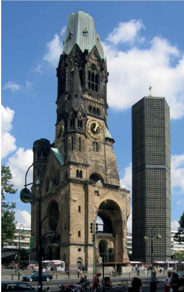
Abb. 3: Berlin-Charlottenburg, Kaiser-Wilhelm-Gedächtniskirche, Aufnahme 2004. Vorhalle mit Hauptturm (1891–1895) von Franz Schwechten und Glockenturm (1959–1961) von Egon Eiermann.
