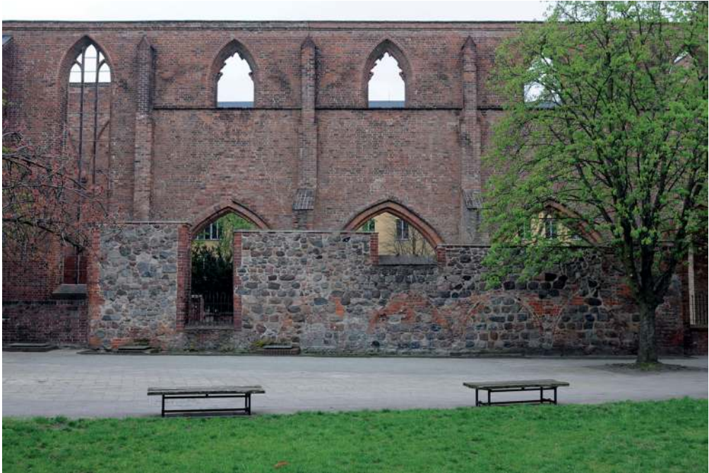
Abb. 1: Nordwand aus Feldsteinmauerwerk.
