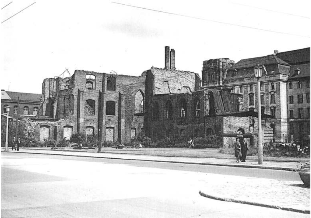
Abb. 13: Gebäudereste des Schulhauses von der Klosterstraße gesehen, Aufnahme 1959.
