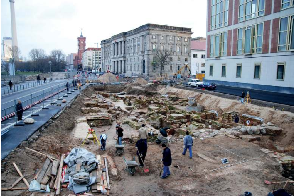
Abb. 3: Freigelegte Fundamente der Dominikanerklosterkirche und späteren Domkirche mit frühneuzeitlichen Grabkammern, Blick gegen Ost im Jahr 2008.
