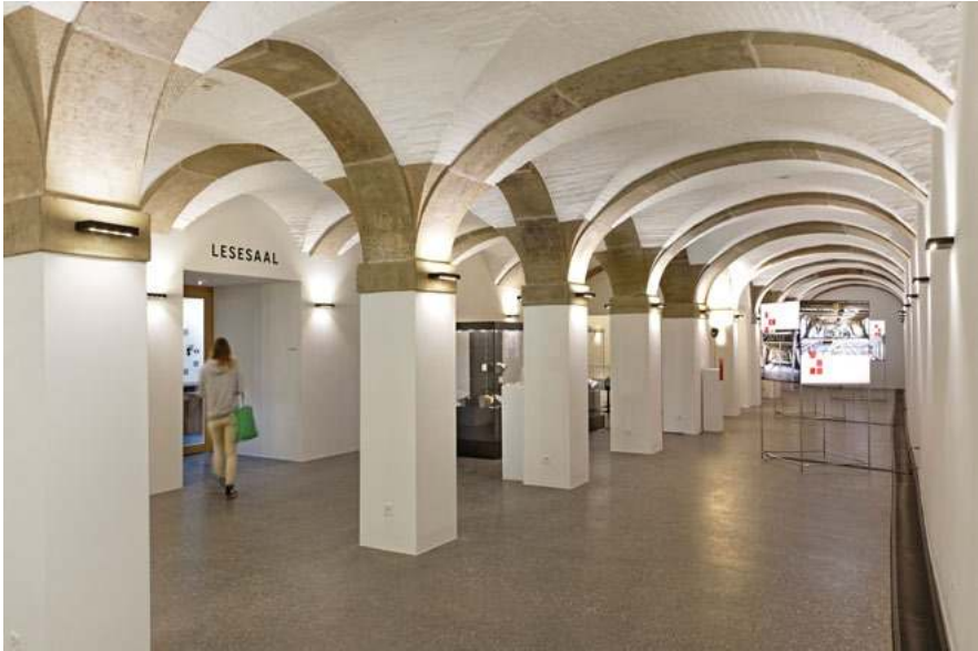
Abb. 8: Bibliothek Münsterergasse, Gewölbekeller 2016. In diesem Raum befand sich bis 2013 die 1952 eingebaute Rollregalanlage, vgl. Abbildung 2 (© Iris Krebs)
