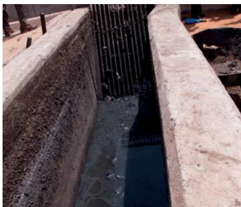
Figure 8.5 : Réservoir de stockage et de mélange utilisé au Sénégal, avec un dégrillage pour éviter le colmatage des lits par des ordures (photo : Linda Strande).
