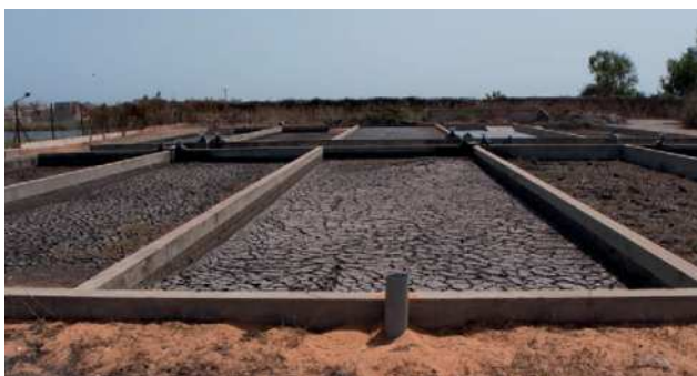
Figure 3.4 : Lits de séchage de la station de traitement des boues de Niayes, Dakar, Sénégal (photo : Linda Strande).
