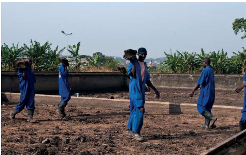
Figure 11.7 : Curage des boues séchées d'un lit de séchage non-planté à la station de traitement de Bugolobi à Kampala, Ouganda (photo : Linda Strande).
