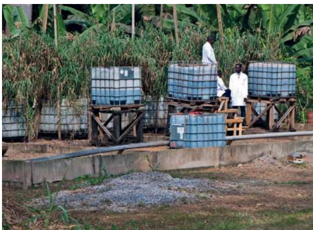
Figure 8.1 : Pilote de lits de séchage plantés pour le traitement des boues de vidange de l'université de Yaoundé (photo : Linda Strande).
