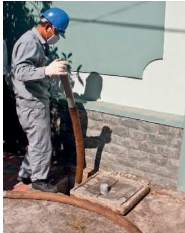
Figure 4.3 : Exemple de regard de visite d'une fosse septique conçue pour permettre un accès rapide, Vung Tau Province, Vietnam (photo : Linda Strande).
