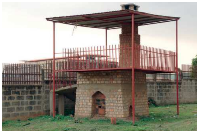
Figure 18.6 : Le four pilote du projet FaME (Faecal Management Enterprises) pour la cocombustion des boues de vidange destinée à la production de briques à Kampala, Ouganda (photo : Pitman Ian Tusheme-zibwe).
