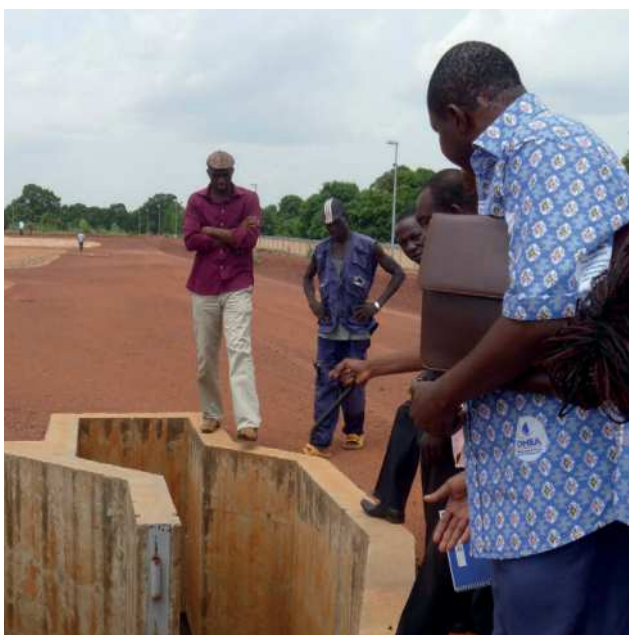
Figure 16.8 : Inspection d'un regard d'entrée, Burkina Faso (photo : Magalie Bassan).
