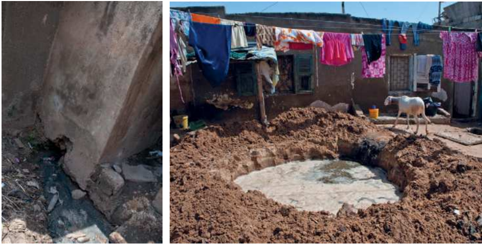
Figure 1.2 : Boues de vidange issues de latrines directement déversées dans un canal de drainage à Kampala, Ouganda (gauche), et vidange des boues d'une fosse septique à proximité d'une habitation à Dakar, Sénégal (photos : Linda Strande).
