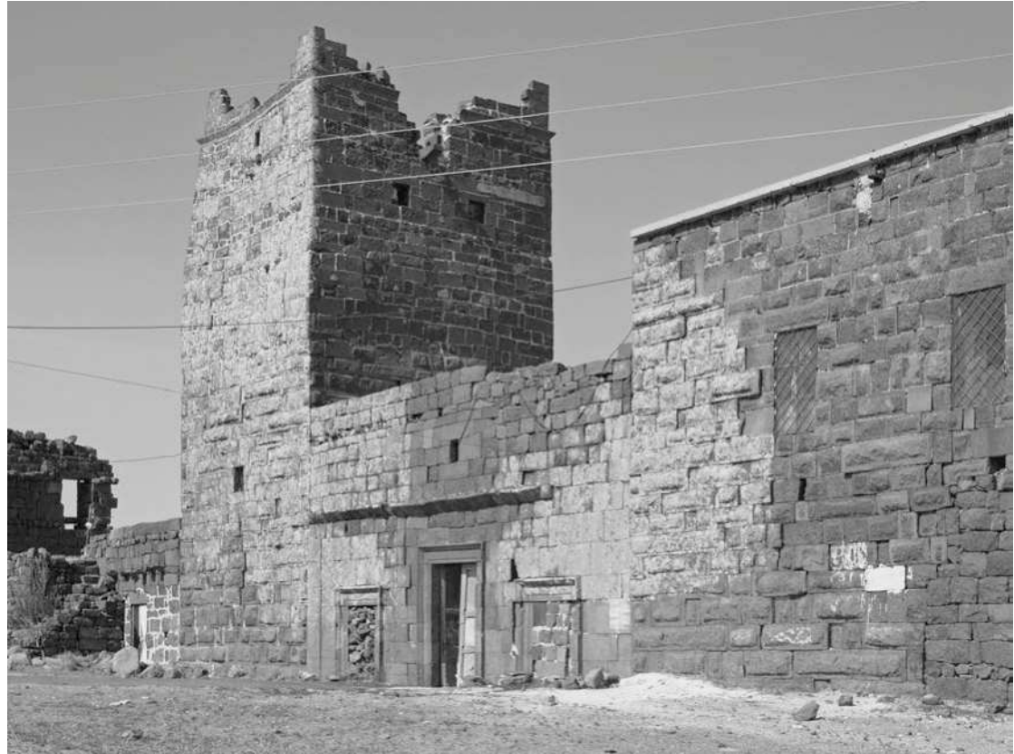
Abb. 15b: Shaqqa, „Ed-Deir“, Westfassade; b: aktueller Zustand
