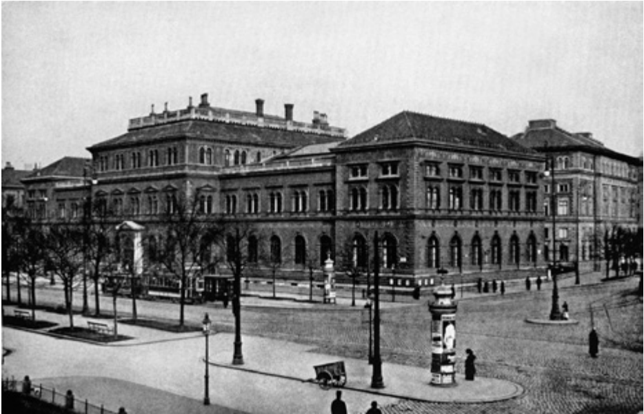
Abb. 1: Das Gebäude des K. K. Österreichischen Museums für Kunst und Industrie am Stubenring; am rechten Bildrand ist der Zubau aus dem Jahr 1908 zu erkennen, 1914.
