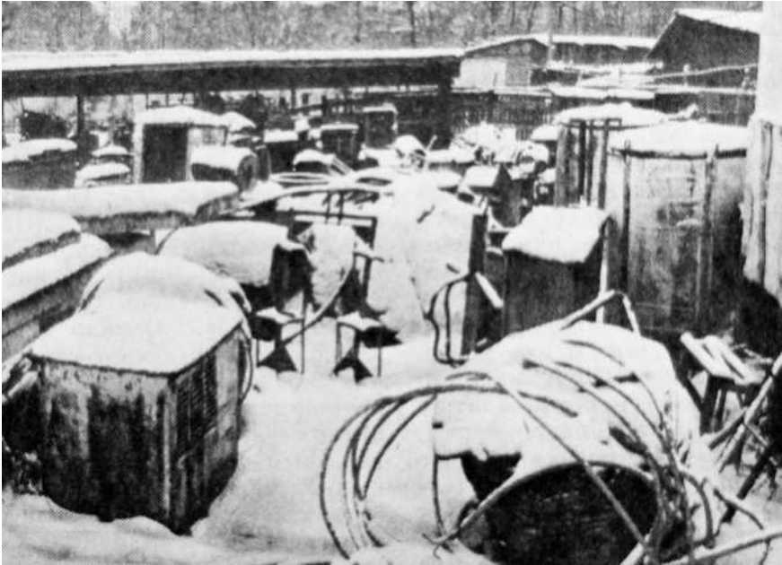
Abb. 7.4.3.6: Offene Misstände. Bau- und Einrichtungsteile eines von Vandalismus und Diebstahl gezeichneten Rehabilitationszentrums in Moskau.
