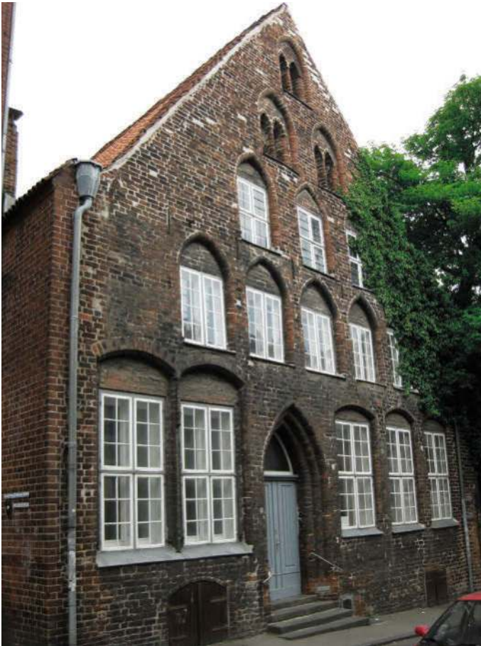
Abb. 13 Lübeck, Kranen-Konvent, straßenseitiger Giebel
