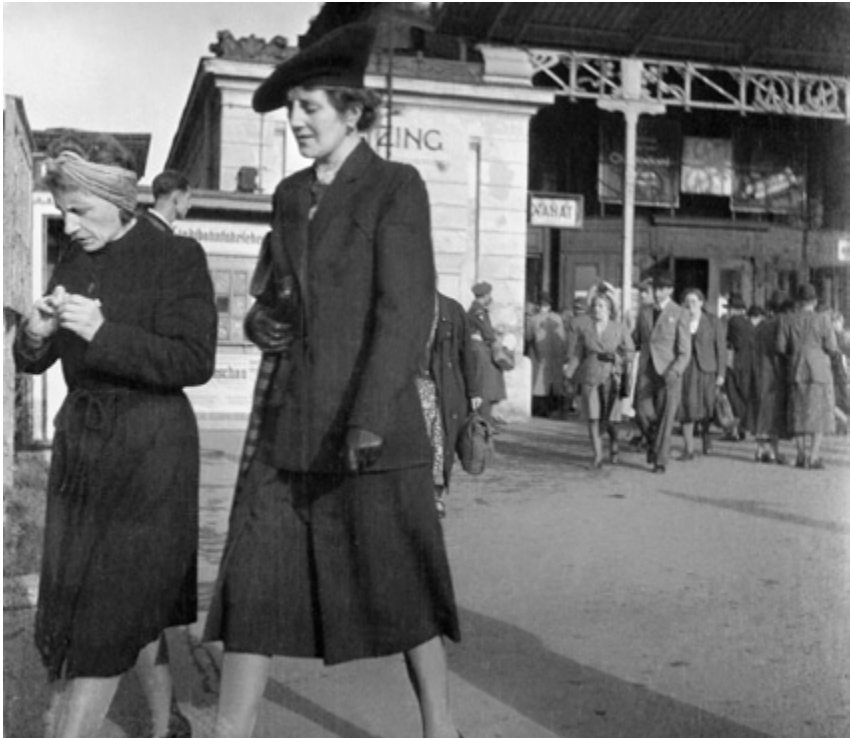
Abb. 62: Stadtbahn-Station Hietzing in Wien. Im Hintergrund ein britischer Besatzungssoldat. (Quelle: AdBIK, Foto: Zajcev)
