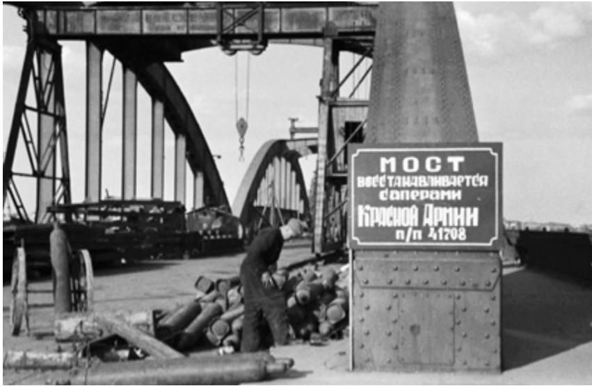
Abb. 18: Eine der zu Kriegsende zerstörten Donaubrücken in Wien, die 1946 mithilfe der Roten Armee wiedererrichtet wurde. (Quelle: RGAKFD)
