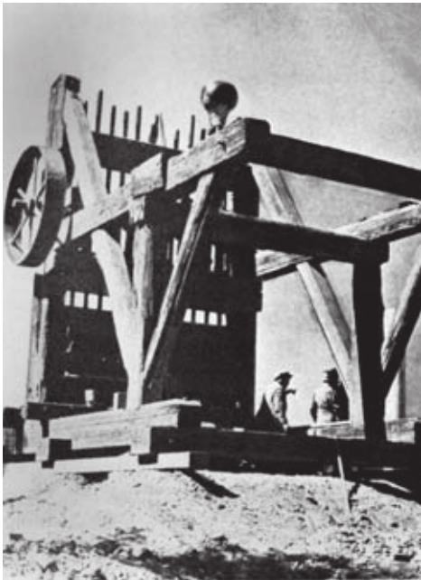
Eines der frühen Stoßwerke an der Robinson-Mine in Johannesburg
