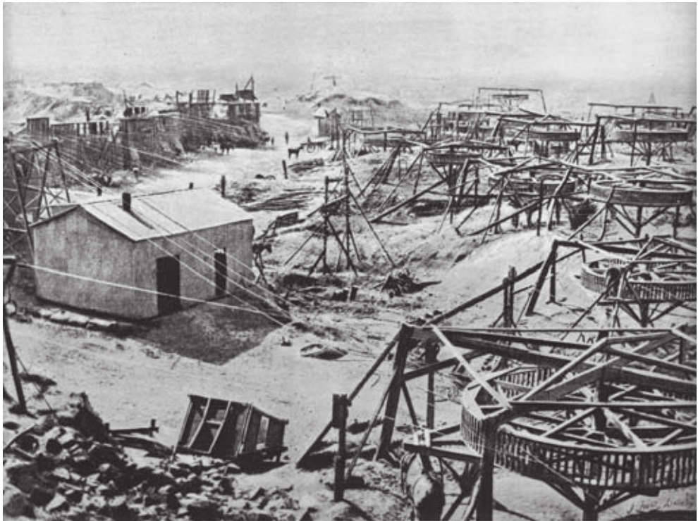
Pferdegetriebene Winden an der Kimberley Mine
