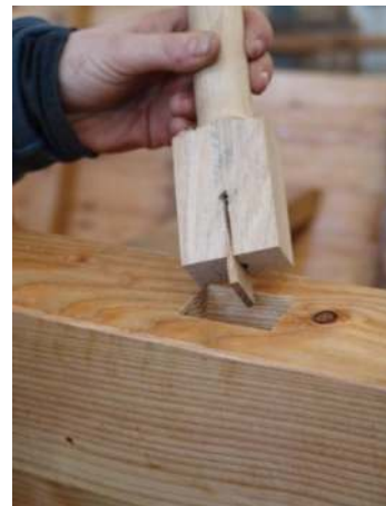
Abb. 6: Zum Einsetzen vorbereiteter Dollpflock mit Keil
