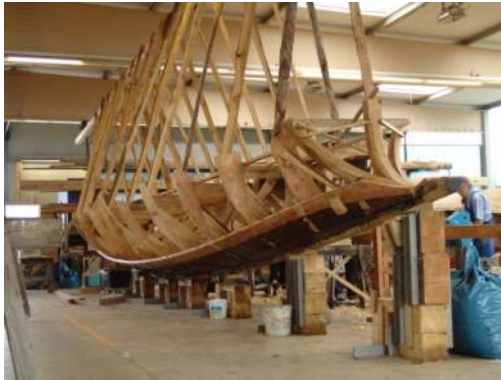
Abb. 5: Die ersten Planken, provisorisch befestigt an den Mallen mit stabilisierenden Schwertlatten zur Decke
