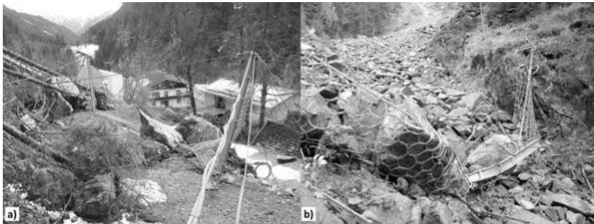
Abbildung 07: Kleiner Felssturz in Hinterhornbach mit einigen 10er m 3 Sturzmasse, Überlastfall für Schutzmaßnahmen (dimensioniert auf 500 kJ) (a); Felssturz im Holderbach mit einigen 100er m 3 Sturzmasse, Überlastfall für Schutzmaßnahmen (b).
