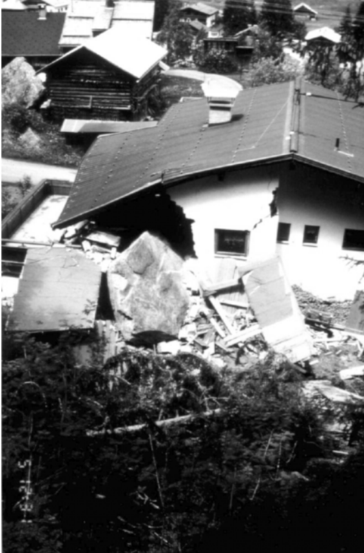
Abbildung 06: See im Paznaun: Großblock mit ca. 30 \text{ m}^3 beschädigt ein Wohnhaus so stark, dass es nicht mehr bewohnbar ist.
