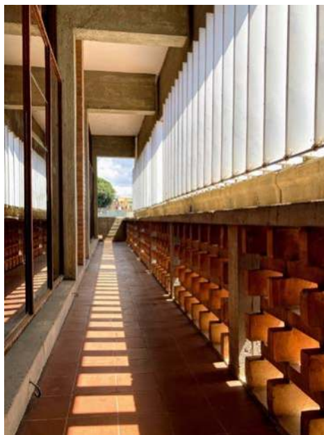
Fig. 6 - Veduta della loggia delle aule delle medie.
