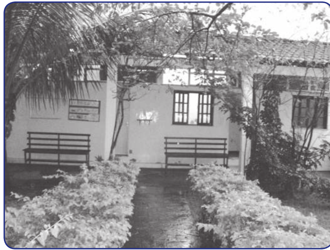
Foto 5 – Sala de espera da Policlínica Newton Bethlen, Jacarepaguá – Rio de Janeiro
