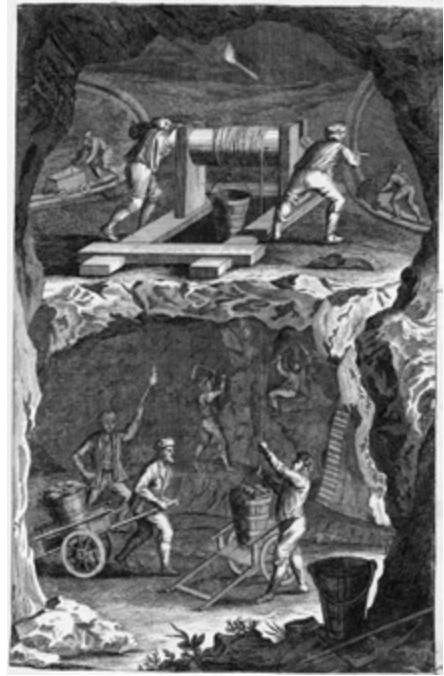
Abb. 136: Stollenarbeit im Salzbergwerk in Hall: Kupferstich aus Franz Gauns Iter per salinas Tyrolenses , Innsbruck 1707.
