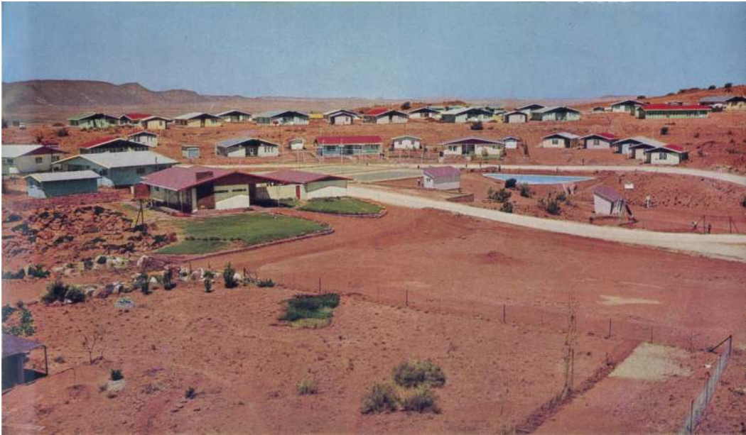
Fig. 128 Photographer unidentified/Department of Information [?]: ‘Das Oviston-Wohngebiet am Eingang des Orange-Vis-Tunnels. Rechts ein Schwimmbad, daneben liegen Tennisplätze.’ (The Oviston living area at the entrance to the Orange-Vis tunnel. On the right is a swimming pool, next to it are tennis courts.), ORP. Südafrika bändigt einen Riesenfluss , c. 1967–1970.
