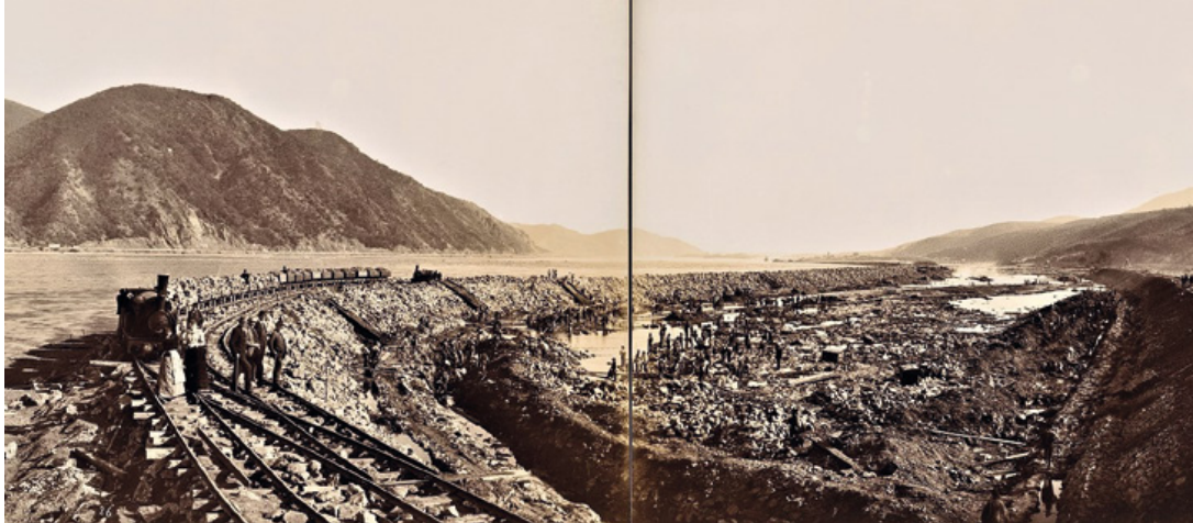
Abb. 3 Arbeiten am neuen Schifffahrtskanal beim Eisernen Tor, Aufnahme von Géza Hutterer Technische Universität, Architekturmuseum Berlin, F 7230
