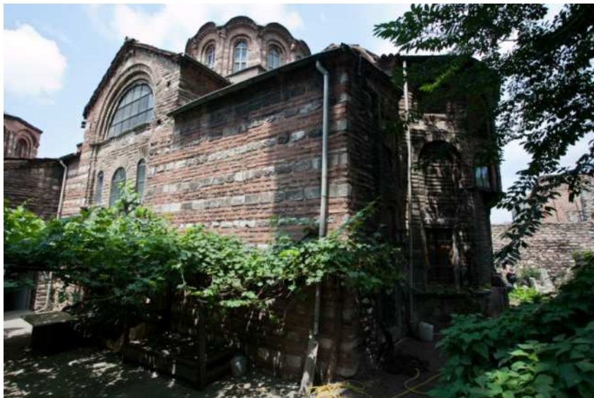
Fig. 9 – Istanbul, Vefa Kilise Camii, naos , muro sud
