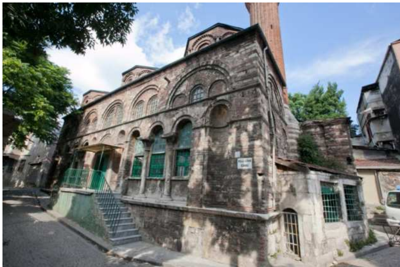
Fig. 1 – Istanbul, Vefa Kilise Camii, da sud ovest
