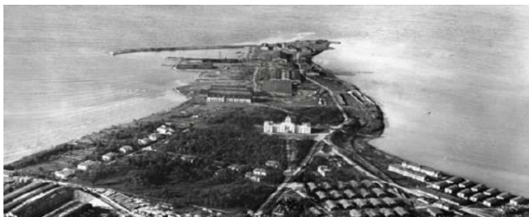
Fig. 9.15. A sinistra, vista dall'alto dell'area Kopli Liinid - Into the Past.
