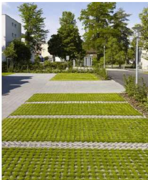
Fig. 6.18. Schema funzionale della Pavimentazione Permeabile (fonte: https://www.lavoripubblici.it ).
