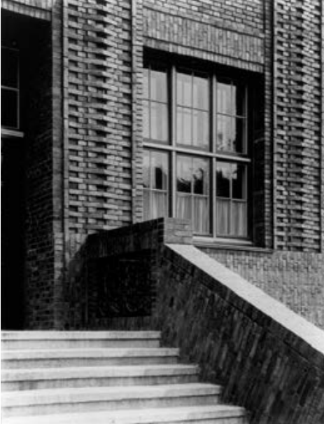
Treppenwange, Gebäude der Kulturwissenschaftlichen Bibliothek, Heilwigstraße 116
