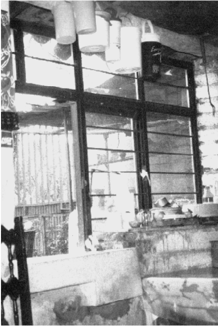
La pila para lavar platos sale al exterior, donde se lava la ropa. Quedando un hueco siempre abierto - casa en Jalisco Rural.
