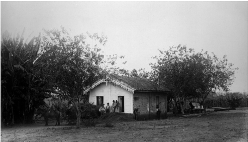
Campos Salles Settlement: settler's house. Campinas (SP), c.1900 (Coleção Secretaria da Agricultura Comércio e Obras Públicas do Estado de São Paulo, Centro de Memória, Unicamp)..
