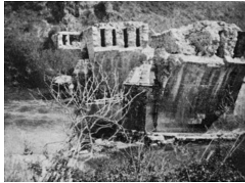
Abb. 4 Die Aisepos-Brücke in Mysien, Ansicht von Westen, frühes 4. oder spätes 5./frühes 6. Jh.
