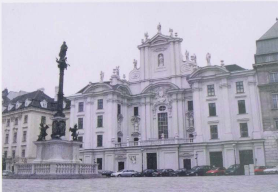
Abb. 103: Fassade der ehemaligen Jesuitenkirche von Filiberto Lucchese, 1667; Platz Am Hof
