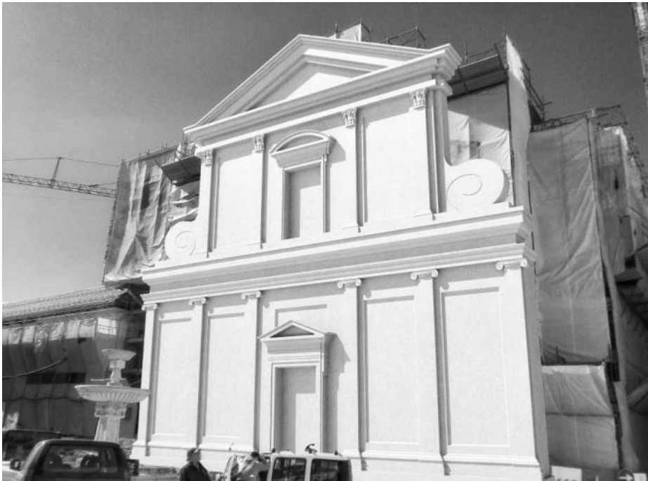
Fig. 3 – L'Aquila, Chiesa di S. Margherita (XVII sec.). Ricostruzione virtuale della facciata mai terminata (modello F. Sicurezza).
