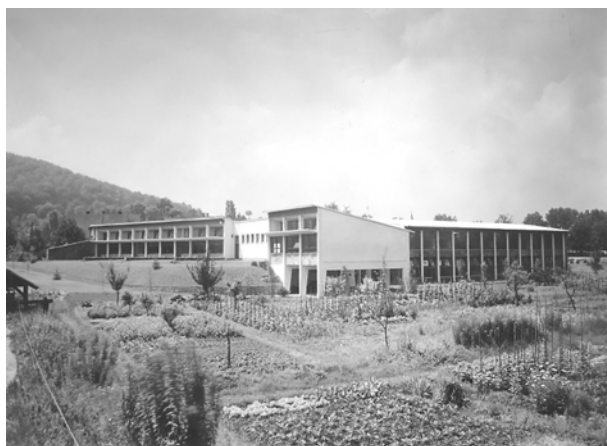
Figure 6: A large garden and light-filled interiors: Primary school by Maria-Verena Fischer in Pfnzthal-Berghausen, 1954. Source: Collection Maria-Verena Gieselmann/saai | Archiv für Architektur und Ingenieurbau am Karlsruher Institut für Technologie (KIT).
