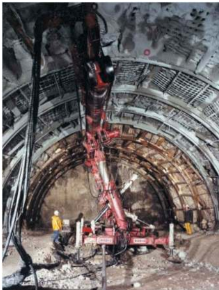
Figure 9. Campiolo Tunnel, Udine-Tarvisio railway line (Lunardi, 2008).
