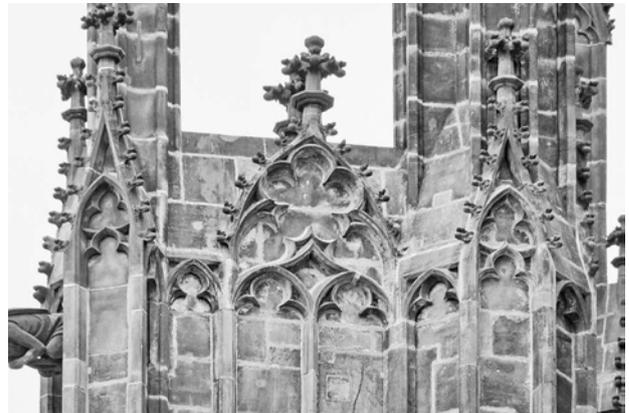
Abb. 13 Prag, Veitsdom, Chorstrebewerk, Blendmaßwerk (Foto: M. T. Huber, 2009)
