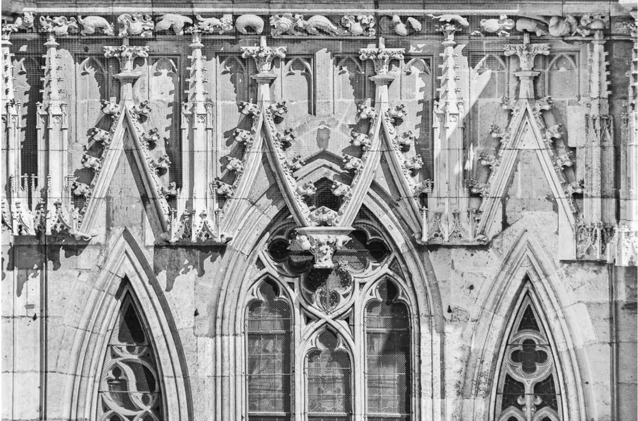
Abb. 20 Regensburg, Dom, Nordturm, Westseite, Erdgeschoss, Fensterzone, Baldachin-Wimperg-Kette (Foto: M. T. Huber, 2009)
