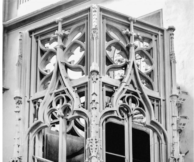
Abb. 5 Konstanz, Münster, Schnegg, Schulterzwiebelbogen. Auf Kragbögen sitzt ein eingezogener und mit Krabben besetzter Kielbogen, der die Form einer Zwiebel annimmt. (Foto: S. King / I. Stadie)
