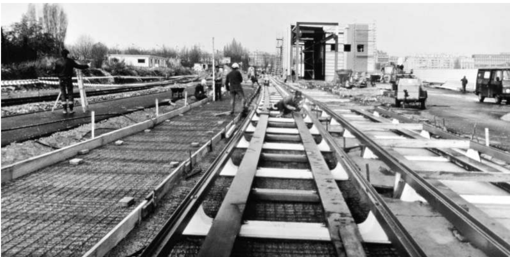
Foto Nr. 10: Der Bau der Versuchsstrecke ist in vollem Gange; das Foto wurde von östlich der Werkstatt aufgenommen. Entlang der Strecke sind die Führungsschienen und die Schiene mit der Stromversorgung deutlich zu erkennen, weiterhin die Führungsschienen für die Radreifen. (Foto RATP)
