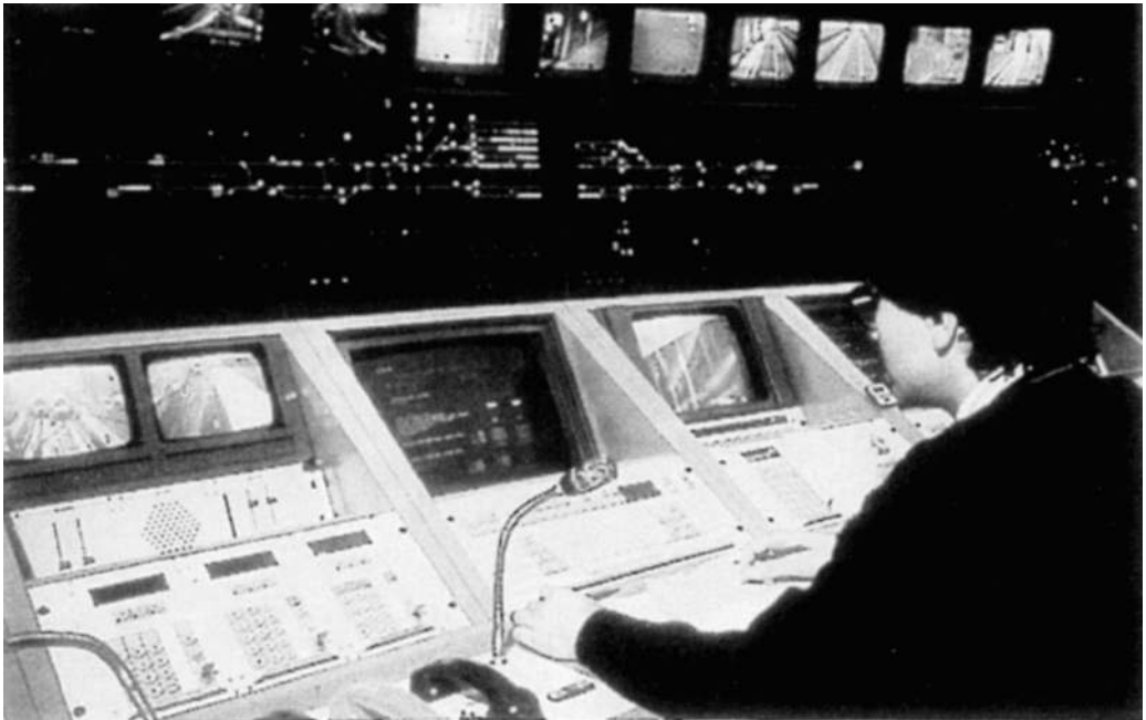
Foto Nr. 7: In Lille, im Kontrollraum des VAL, des großen Bruders von Aramis, dessen Erfolg den kleinen Aramis in den Schatten gestellt hat. Die Hauptinnovation besteht darin, dass die ehemaligen Zugführer jetzt vor einem Steuerpult sitzen, von dem aus sie die Fortbewegung der automatischen Züge aus der Distanz verfolgen. (Foto: Matra)
