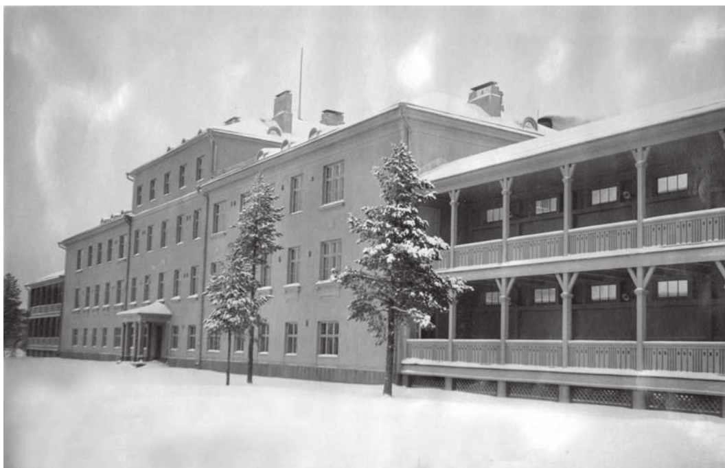
Kuva 10. Vuonna 1927 avattu Muurolan tuberkuloosiparantolan päärakennus Rovaniemellä. Hallimakuuparvekkeet, jotka mahdollistivat levon raittiissa ulkoilmassa, olivat olennainen osa tuberkuloosihoitoa (Helsingin yliopistomuseo).
