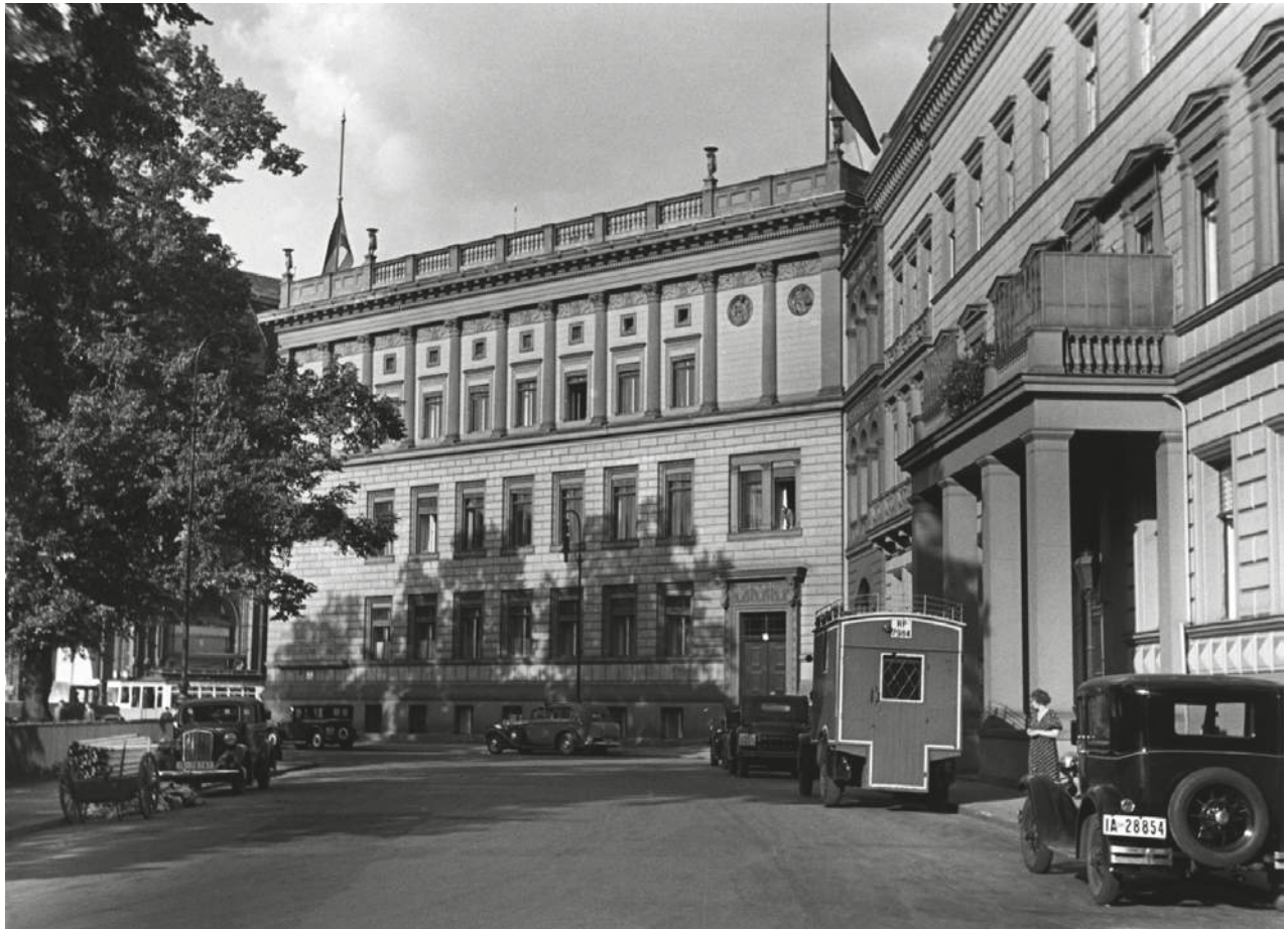
Abb. 50: Rechts im Bild erscheint die Fassade des Preuß. Ministeriums für Landwirtschaft, Domänen und Forsten in Berlin, Leipziger Platz Nr. 10. Richard Falck hat hier verschiedene Male vorgesprochen. Das sich anschließende Gebäude im Mittelgrund zeigt das 1934 errichtete Reichsforstamt, Leipziger Platz Nr. 11 (Aufnahme 1935). 771
