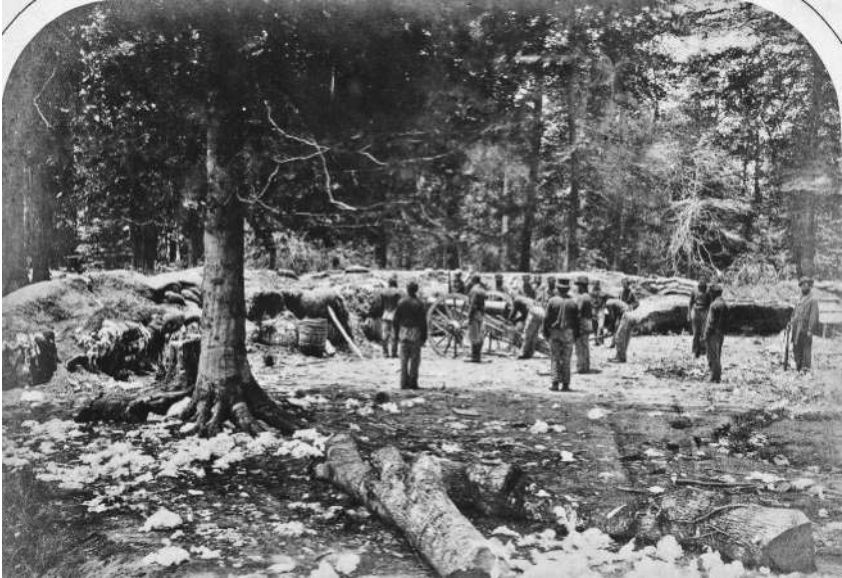
Abb. 7: Aus Baumwollballen errichteter Schutzwall einer Unionsbatterie in Louisiana, 1863.
