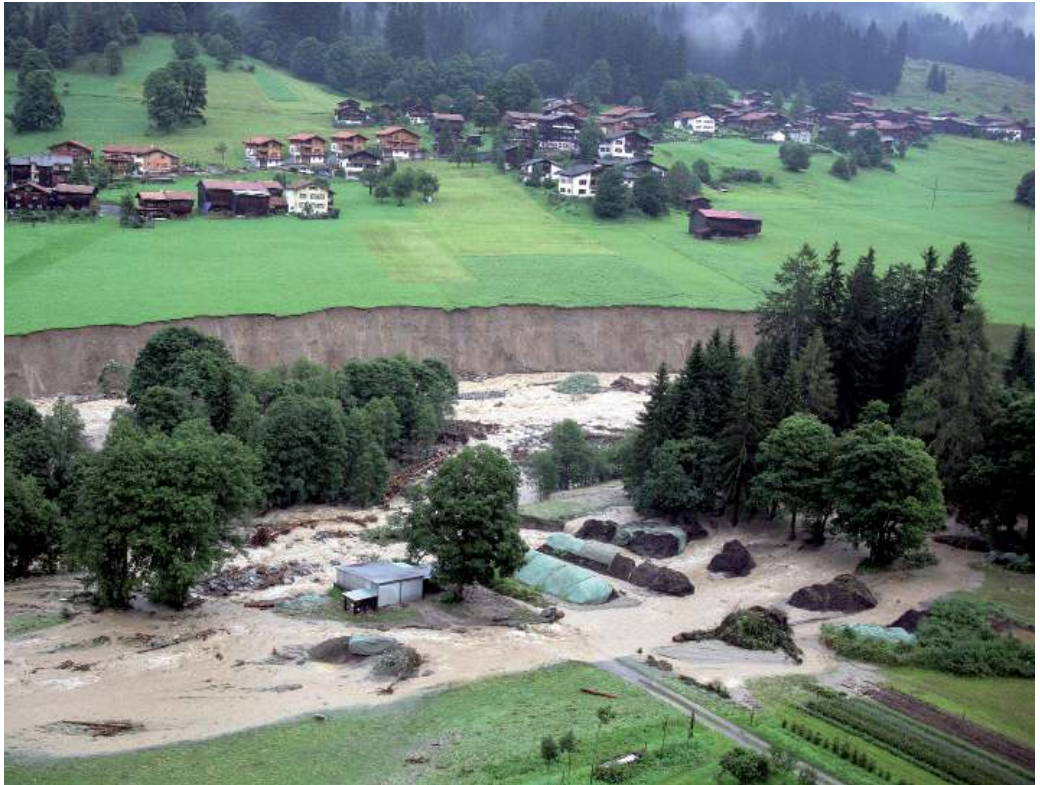
Klosters (Graubünden/Schweiz): die korrigierte Landquart verursacht ausgedehnte Ufererosionen und kehrt streckenweise in ihr ehemaliges Gerinne zurück, Hochwasser 2005 (Quelle: Gebäudeversicherung Graubünden / GVG)
