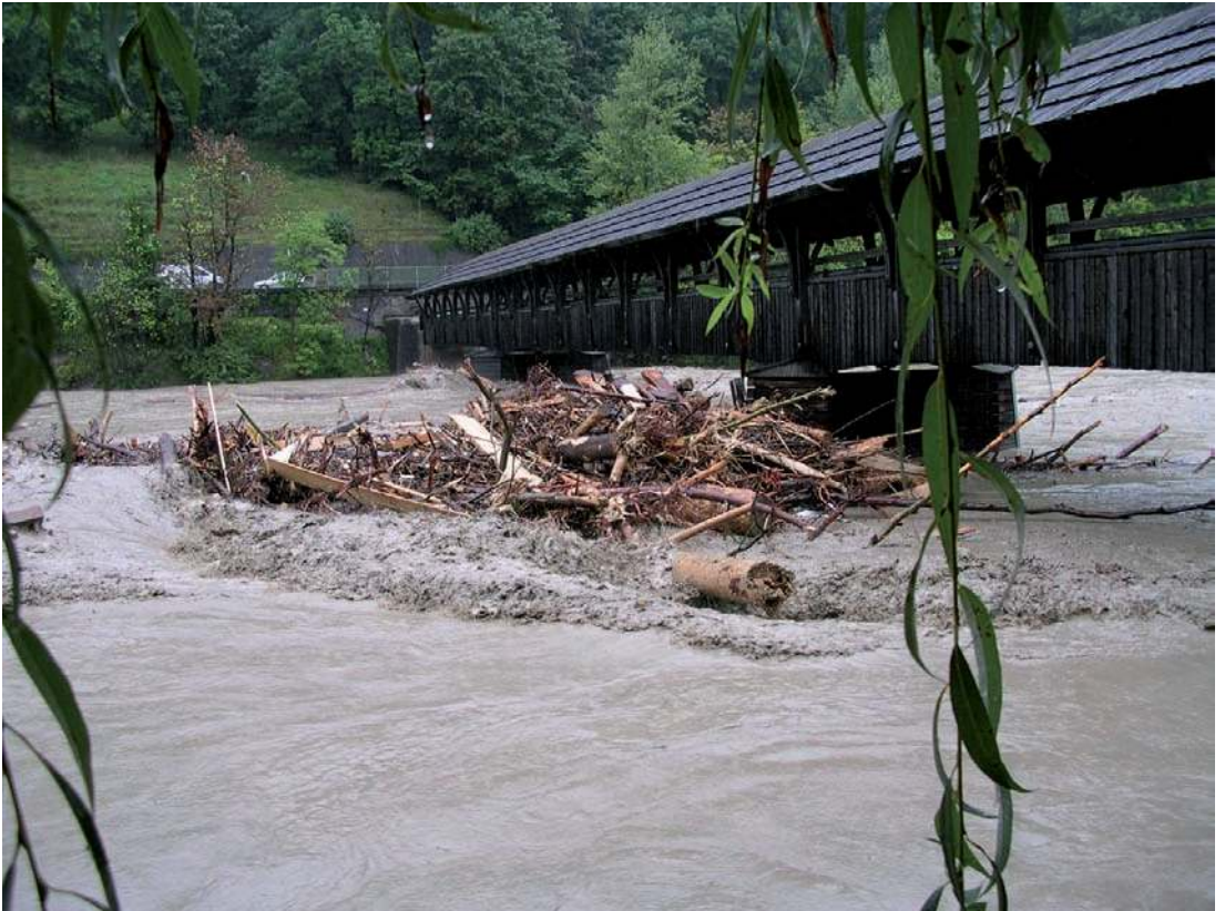
Innsbruck (Tirol/Österreich): Verklausung im Inn am Psenner-Steg, Hochwasser August 2005 (Quelle: alpS)
