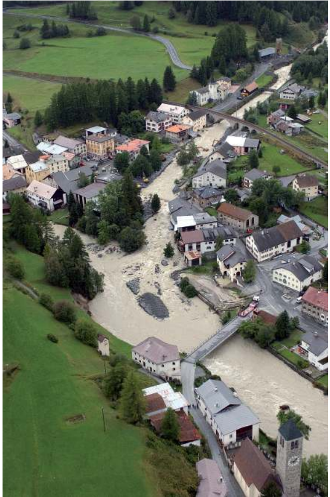
Susch (Graubünden/Schweiz), Ufererosion im Inn, Hochwasser August 2005 (Quelle: Gebäudeversicherung Graubünden / GVG)
