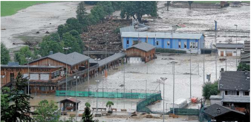
Klosters (Graubünden/Schweiz): ausgedehnter Wasserübertritt durch Verkläusung (Schwemmbolz), Hochwasser August 2005 (Quelle: Gebäudeversicherung Graubünden /GVG)
