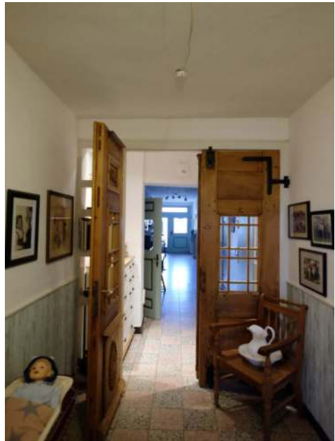
4-96 (oben) – Historische Holzkonstruktion, Stahlträger und -stützen im Wirtschaftsteil. Lüder, 2018.
