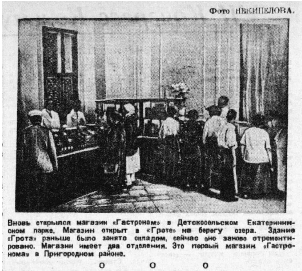
Abb. 10: Das Lebensmittelgeschäft Gastronom war für die Bewohner von Detskoe Selo und Leningrad ein Novum. Es wurde im Grotten-Pavillon am Ufer des Großen Sees im Katharinenpark untergebracht. Die Abbildung zeigt das Interieur des Gastronom .
