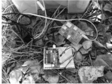
Fig. 6 - Il data logger sperimentale (ingrandimento sui sensori e sul microcontrollore)
