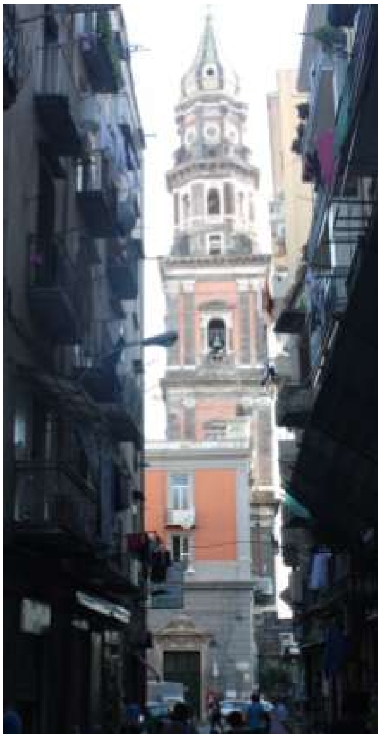
Fig.62: Napoli, il campanile del Carmine.
