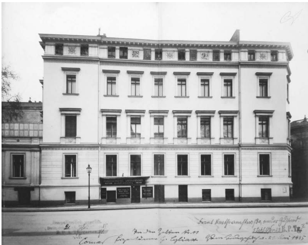
Abb. 1: Ansicht des Hauses In den Zelten 11 (Foto aus der Bauakte von 1935, Landesarchiv Berlin)
