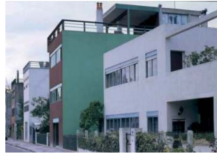
FIG. 13 The Pessac-colony today [Source: Fondation Le Corbusier].
