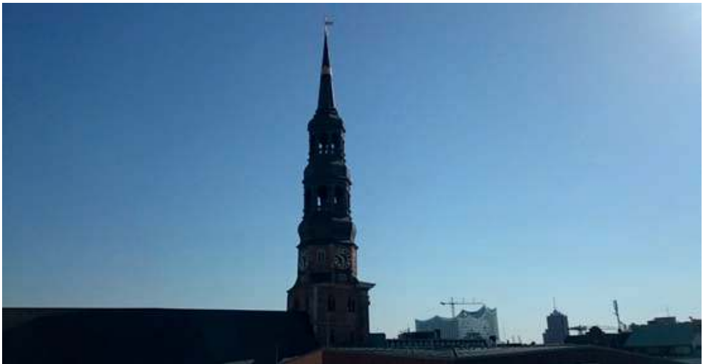
... Architektur-Mix 2015: St. Katharinen mit neuem Turm, dahinter die Elbphilharmonie im Bau ...
