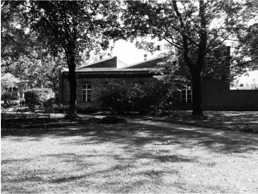
Abb. 17 Baracken mit verschlossenen Shed- bzw. Sägezahndächern der geschlossenen Venerologischen Station im Stadtkrankenhaus Prenzlauer Berg (2015)
