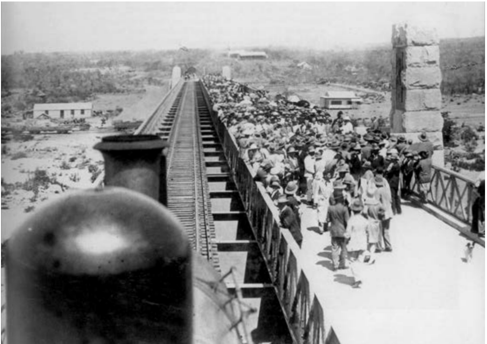
Die Alfred-Beit-Bridge über den Limpopo, 1927–1929 errichtet durch den „Beit-Trust“
