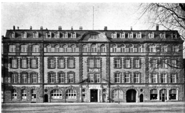
Abb. 1: Seminargebäude der Universität am Bornplatz. Vorderansicht (Das Psychologische Institut nimmt das II. Stockwerk ein)
