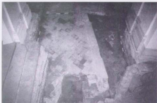
Abb. 91: Schloß Schönbrunn, Hauptbau, Mittelbereich; Grabungsfund vom Gonzagaflügel 1994/95. Etwa drei Meter breite Stufe des Eingangsportals mit der Ziegelpflasterung des Vorraumes.
