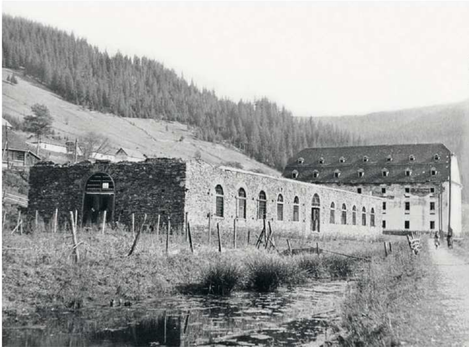
Abb. 67: Die Ruine der ehemaligen Manzschen Gießereihalle in Jakobený, wie sie in der Zwischenkriegszeit noch Bestand hatte, wurde mit dem staatlichen Industrialisierungsprogramm des sozialistischen Rumäniens wahrscheinlich während der 1960er Jahre endgültig abgetragen. 80
