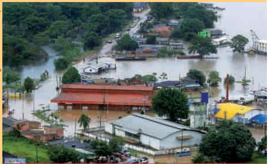
Dégâts liés à la crue du rio Madeira en 2014 au Brésil.
