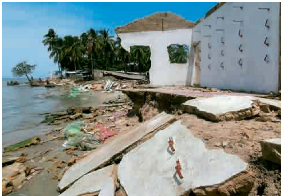
Érosion côtière au Sénégal.
