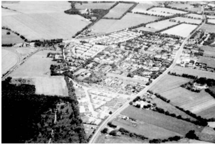
Abb. 1: Luftbild des Ortsteils Ulzburg Süd mit der Lage des geplanten Ortsteils Beckershof
