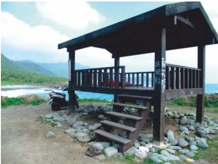
Abbildung 21: Moderne tagakal außerhalb des Dorfes Ivalino – Unterstand mit erhöhtem Boden ohne Wände.
