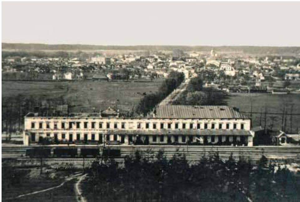
Stadtplannr. 1c : Blick über den zerstörten Bahnhof auf die Bahnhofstraße zum Stadtzentrum Brodys (links Synagoge, Mitte Mariä-Geburts-Kirche) um 1920.
