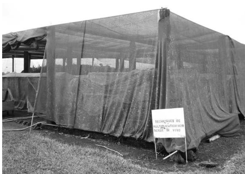
Photo 5.14. Ombrière en matériau définitif. © M. Kwa
