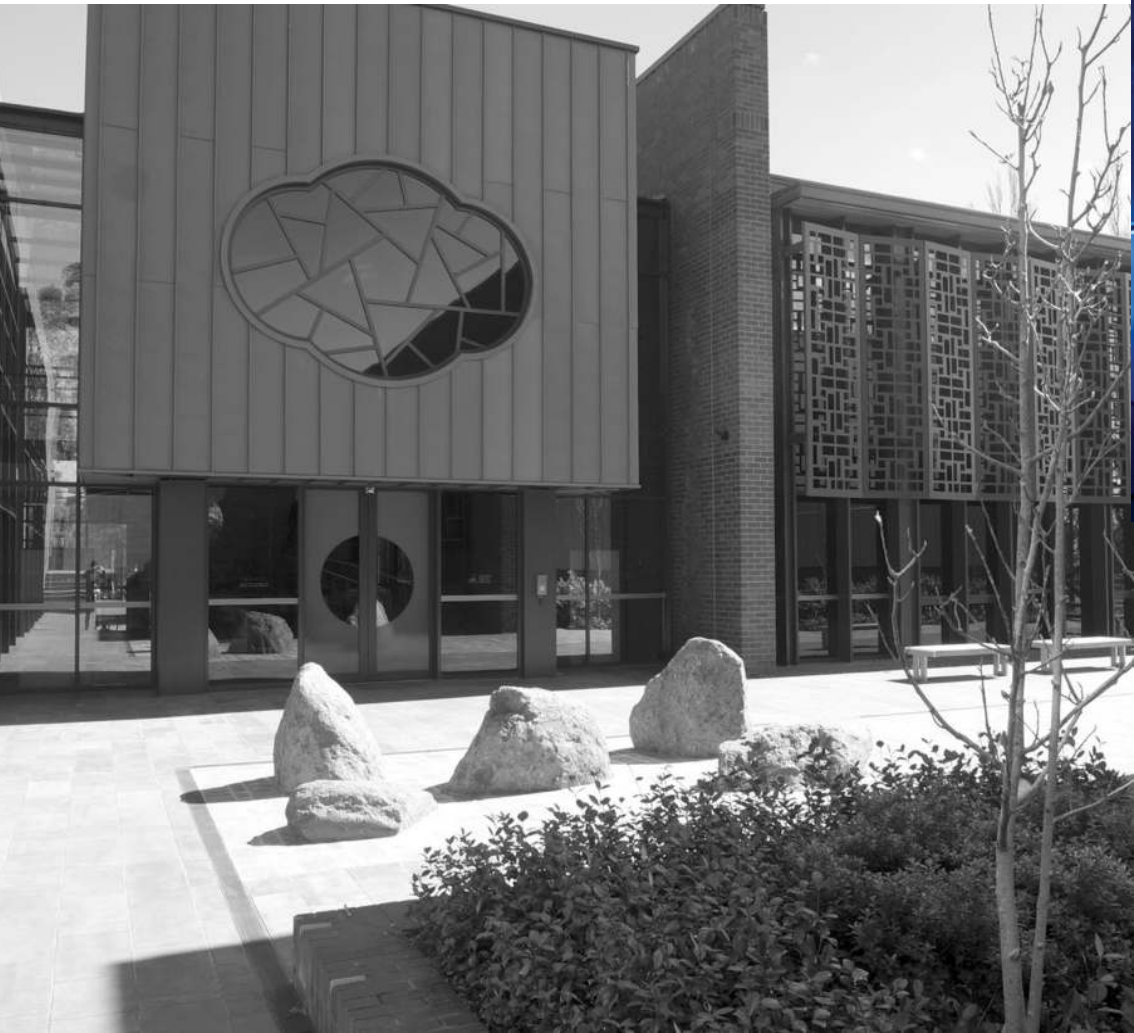
External view of the Australian Centre on China in the World. 中华全球研究中心建筑局部外观。
